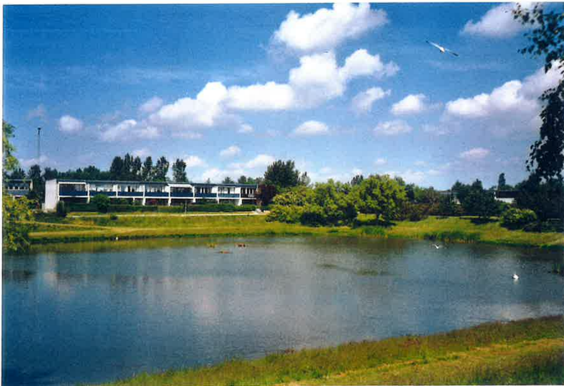
RVP grænser op til flere offentlige, grønne anlæg. Herunder et naturligt formet regnvandsbassin.
