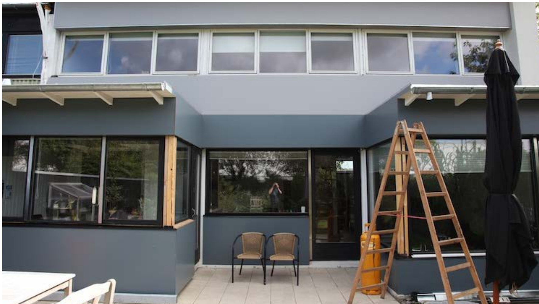
Renovering af D26
