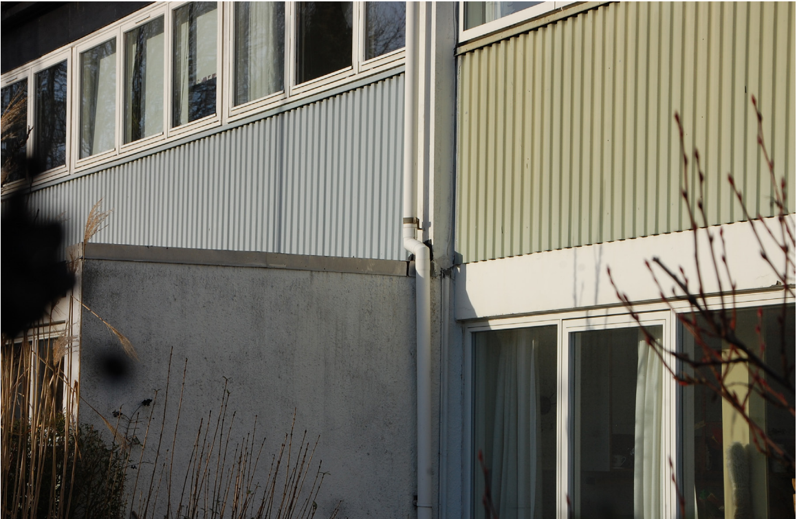
Havefacader Syd- og vestvendte facader (haveside) Facaderne er opbygget som en let konstruktion med pladebeklædning.
