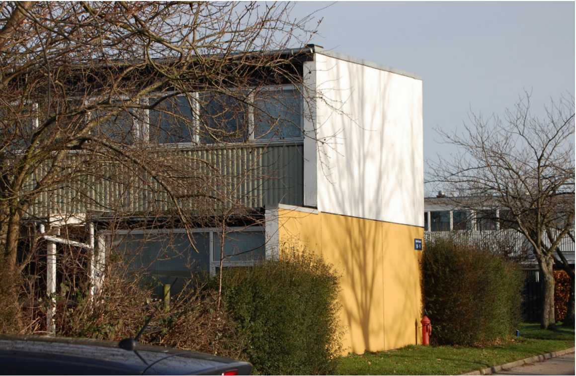
Gavle De eksisterende gavle er bygget af sandwichelementer med begrænset isolering.
