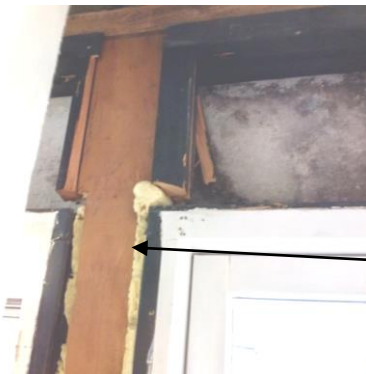
Forud: Vinduerne var fastgjort til resterne af vinduessektion fra husenes oprindelse, som var gennemsavet - Taget var således båret af vinduessektionerne
