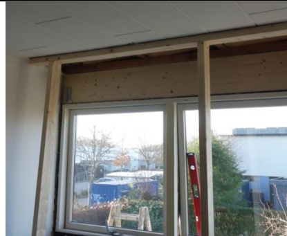
Understøttelse og nye bjælke lagt ind ovenpå gamle vindue ...
