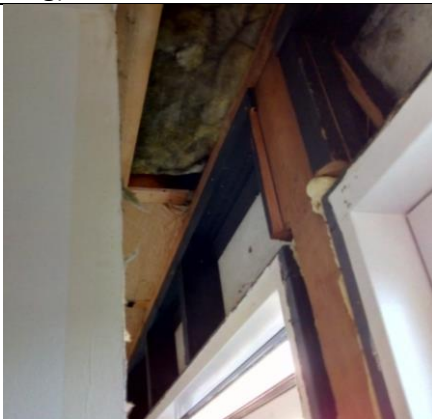
Forud: Husenes oprindelige konstruktion var gennemsavet og erstatningsvinduerne indsat og fastgjort til denne. Ingen stolper mellem de tre vinduesfag.
