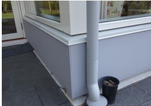
Forbedret isolering udadtil (havesiden stueetage)
