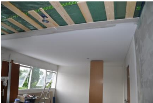
Tv: Nye loft, (OBS genetablering af loft i rum 1 forud for påbegyndelse af renovering af rum 3)
