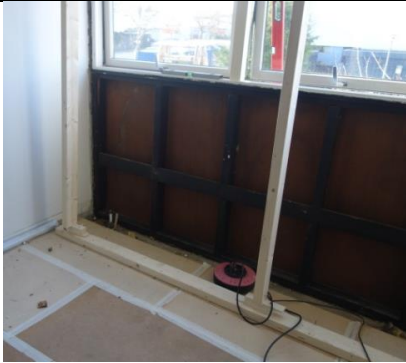
Punkt 1 – Understøttelse af loft/tag (midlertidig)
